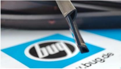
**Schritt 1 – Dichtung zuschneiden:** Fensterbank-Anschraubdichtung AD 500 auf die exakte Länge der Fensterbank inklusive Fensterbankabschluss mit geeignetem Werkzeug zuschneiden.
