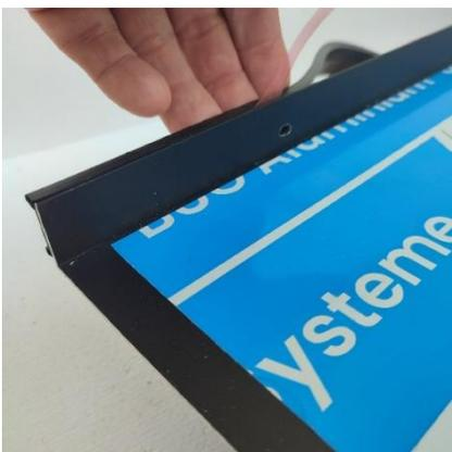
**Schritt 4 – Folie abziehen und andrücken:** Schutzfolie des Dichtklebebands schrittweise abziehen und Anschraubdichtung über den gesamten Fensterbankanschraubsteg fest andrücken.
