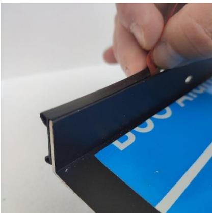
**Schritt 3 – Dichtung positionieren:** Tropfkante der Anschraubdichtung am Anschraubsteg der Fensterbank positionieren, Dichtung festhalten und andrücken.
